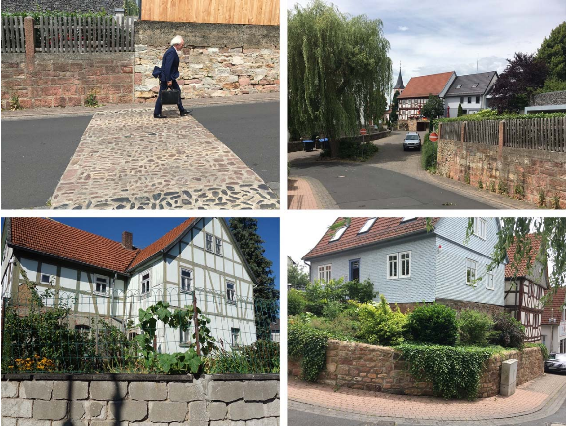
Abb.: 6 Charakteristische Grundstücksmauern aus Naturstein
