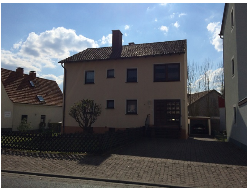
Bild 35: Gersfelder Straße 12 - Wohngebäude
