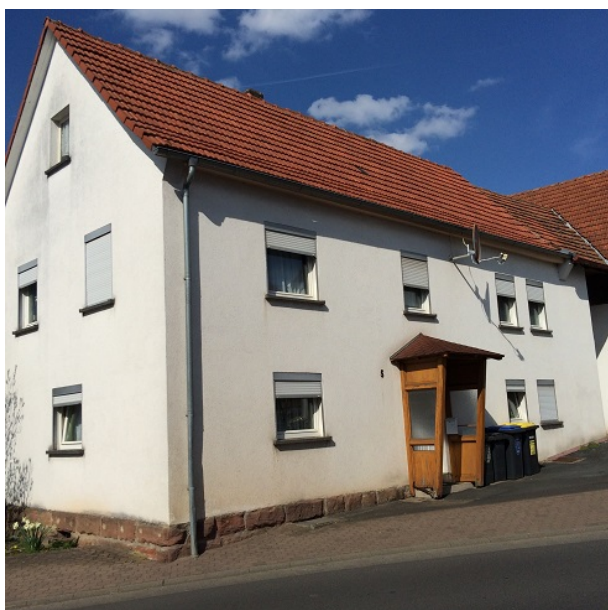
Bild 37: Gersfelder Straße 5 – Wohngebäude
