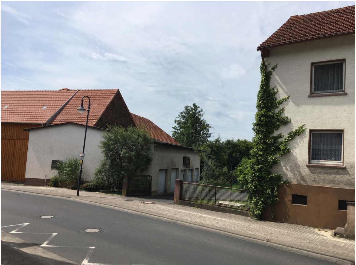
Abb.: 23 Bestandsgebäude Fuldaer Straße 3
