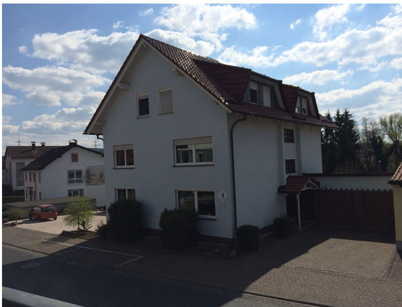
Bild 26: Fuldaer Straße 9 - Wohnhaus
