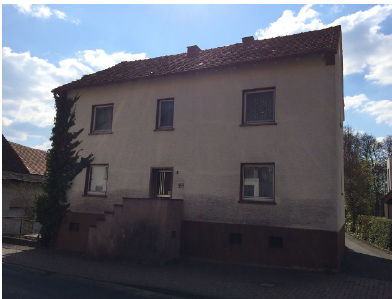
Bild 23: Fuldaer Straße 3 – zur Zeit leerstehendes Wohngebäude
