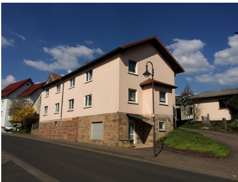
Bild 27: Fuldaer Straße 6 - Wohnhaus
