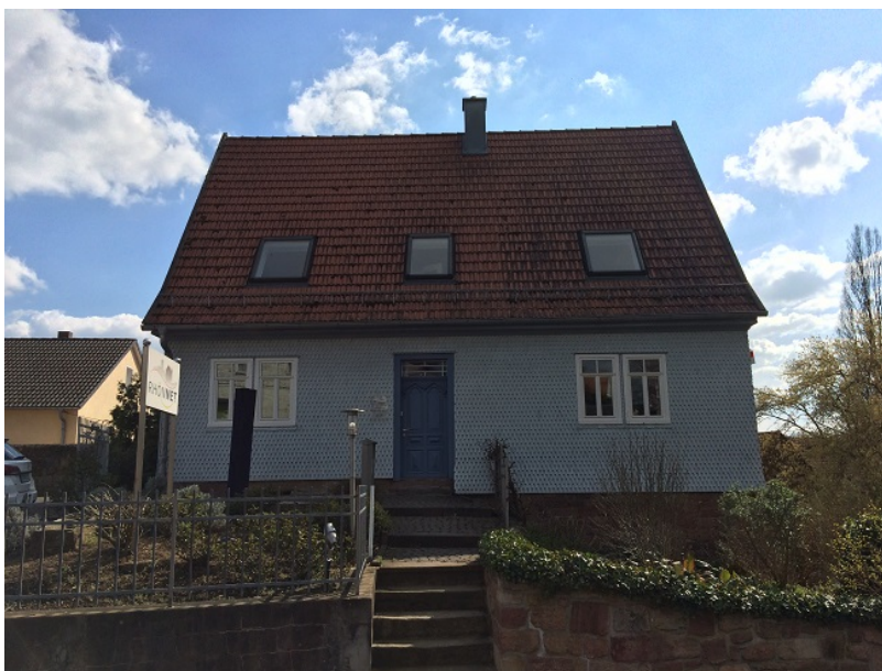
Bild 33: Turmstraße 10 – Wohngebäude (aktuell gewerbliche Nutzung)
