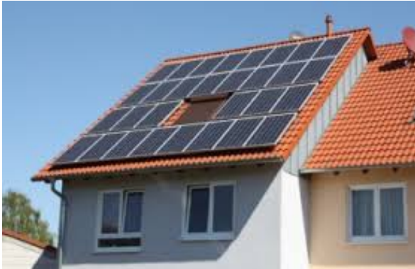
Bild 40: Beispiel PV-Anlage auf Hausdach
