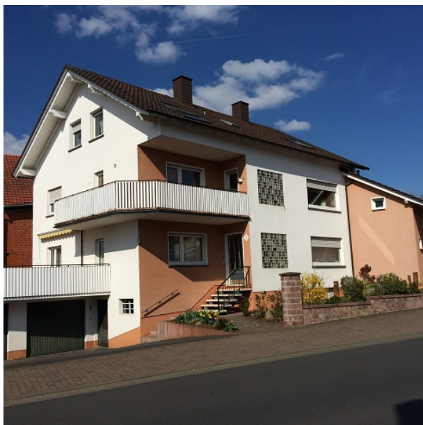
Bild 36: Gersfelder Straße 3 – Wohngebäude
