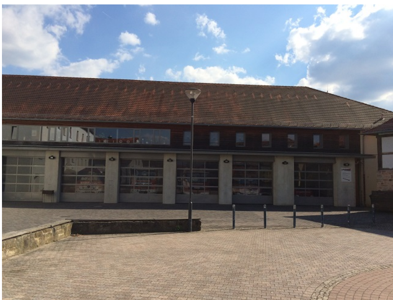
Bild 21: Am Hof 4 - Feuerwehrgerätehaus
