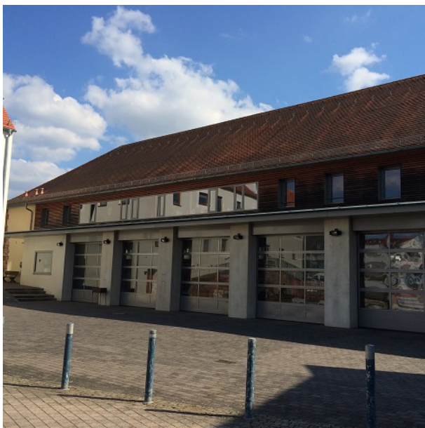
Bild 20: Am Hof 4 – Feuerwehrgerätehaus (Denkmal)
