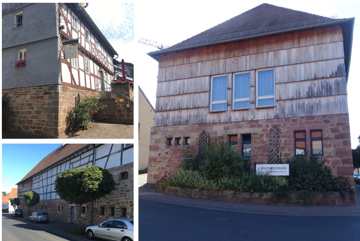
Abb.: 8 Gebäudesockel aus Natursteinmauerwerk, Fachwerkhäuser
